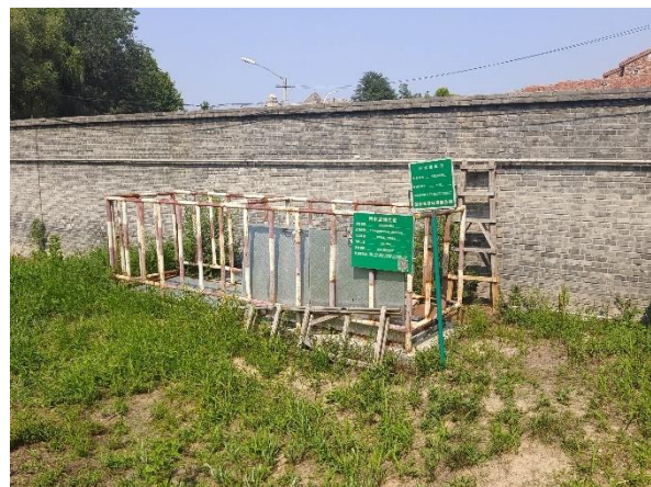
污水处理站出水口
